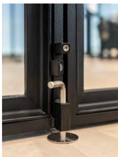
Feststeller eines Türflügels latch of a door wing
